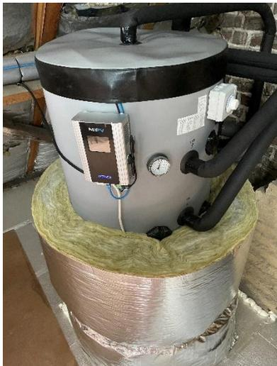
Ein weiterer AC•THOR regelt die Beheizung des 200 Liter Tanks für die Warmwasserbereitung des Hauses.
